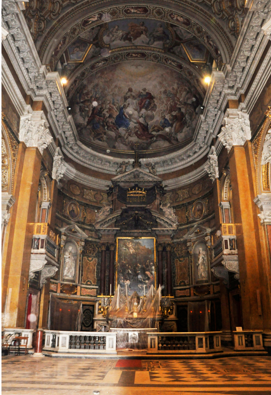
3.1 Abside - Vista panoramica
