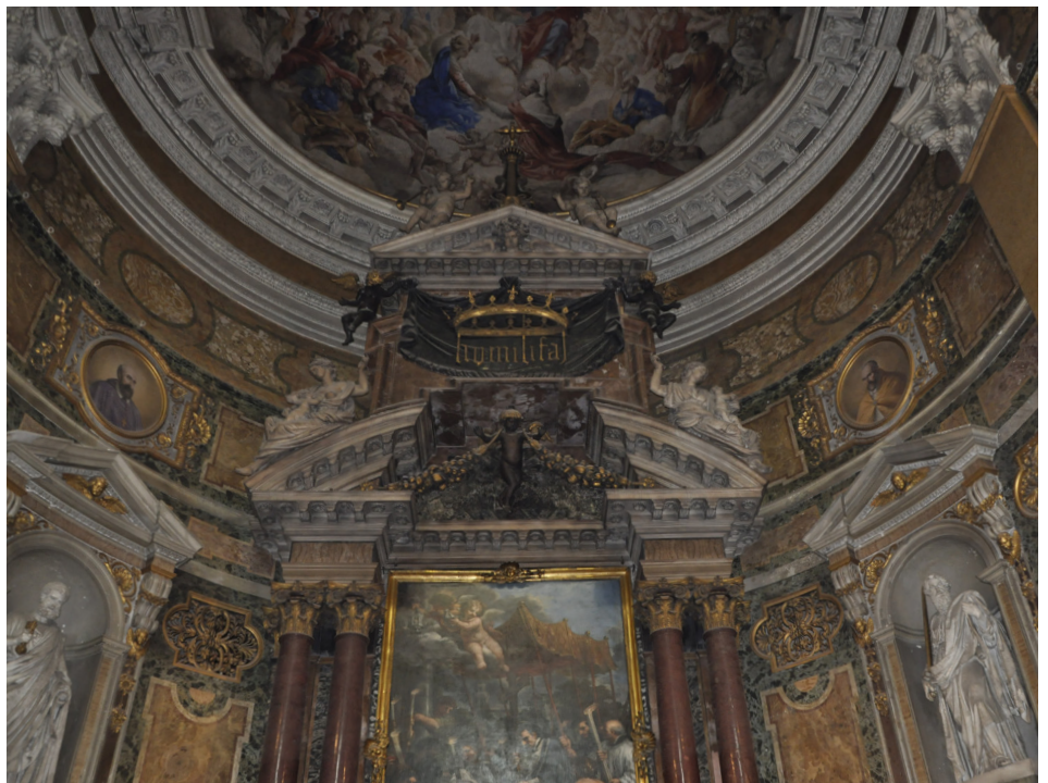
3.3 Parete dell'abside - Decorazioni a stucco e intonaci dipinti a finto marmo
