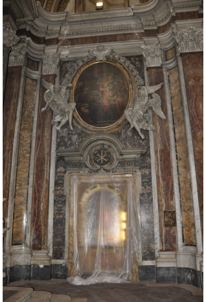
8.2 Parete laterale destra
