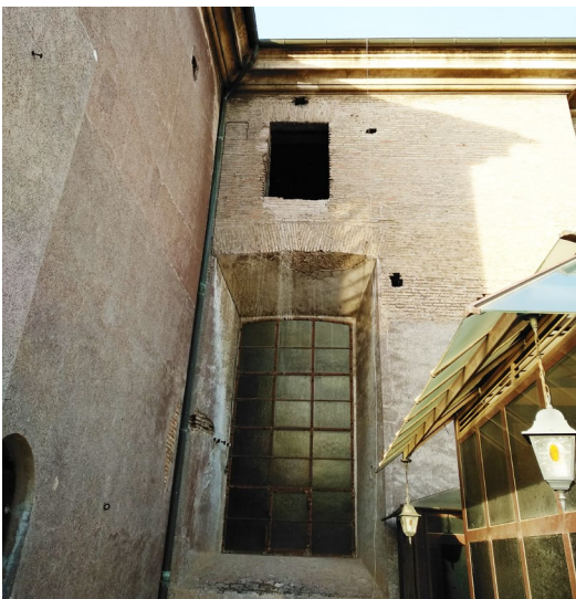
Finestratura presbiterio: percolazioni di acque meteoriche e lacune d'intonaco
