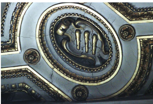
Lacunare volta su N3: fenomeni di deposito, cavillatura e fessurazione
