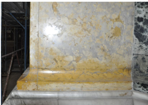
Lastre di rivestimento della parasta: fenomeni di alterazione cromatica nei punti più raggiungibili, attribuibile ad interventi antropici impropri
