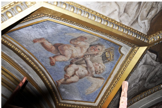
Campo dipinto in prossimità della finestra del presbiterio: fenomeni di fessurazione ed efflorescenza
