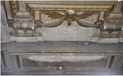
Cornice in stucco della finestrazione della controfacciata: fenomeni di efflorescenza dovuti alla scarsa tenuta dell'infisso
