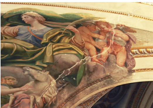
Affreschi sui pennacchi con evidenti stuccature eseguite durante gli interventi di messa in sicurezza del 2013
