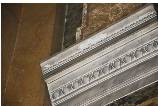
Cornice in stucco con finitura a finto marmo: fenomeni di sollevamento e perdita della pellicola pittorica
