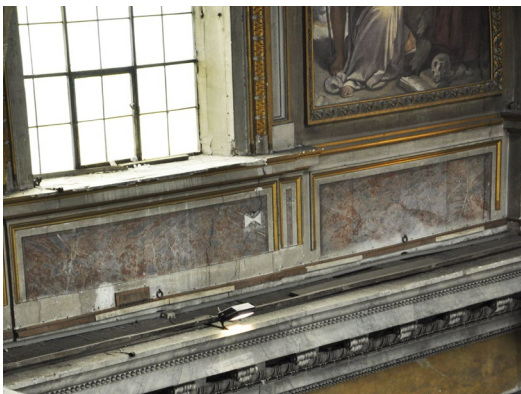
Infisso dell'apertura sul transetto: fenomeni di percolazione, efflorescenza e fessurazione
