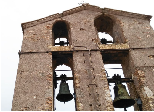
Campanile: fenomeni di degrado dell'intonaco
