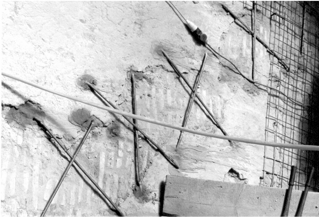
Fig. 45. Foto relativa alla perizia n. 13 del 7 maggio del 1994 (1° lotto consolidamento). Dalla foto si osserva la posa in opera di spezzoni di tondino in acciaio con estremità piegate a 90° per l'inserimento nei fori predisposti.
