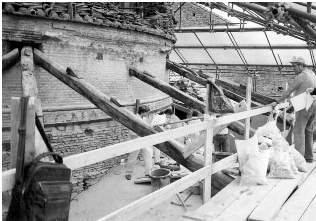
Figg. 47-48. Foto relativa alla perizia n. 13 del 7 maggio del 1994 (1° lotto consolidamento). Dalle foto si possono osservare le cerchiature in ferro forgiato poste a cingere il tamburo della cupola.
