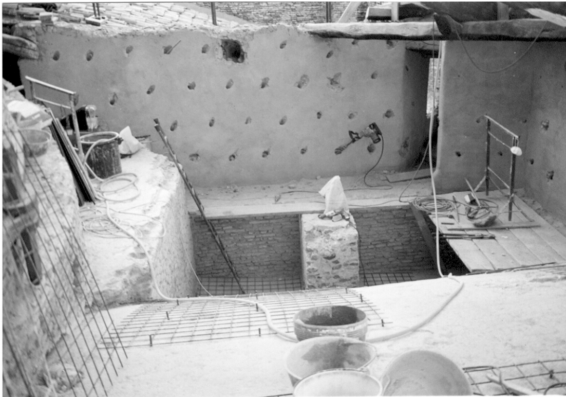
Fig. 43. Foto relativa alla perizia n. 13 del 7 maggio del 1994 (1° lotto consolidamento). L'immagine, scattata durante i lavori di consolidamento delle murature eseguiti dalla Soprintendenza, riporta i fori dove sono state eseguite le iniezioni di biacca fluida di cemento.
