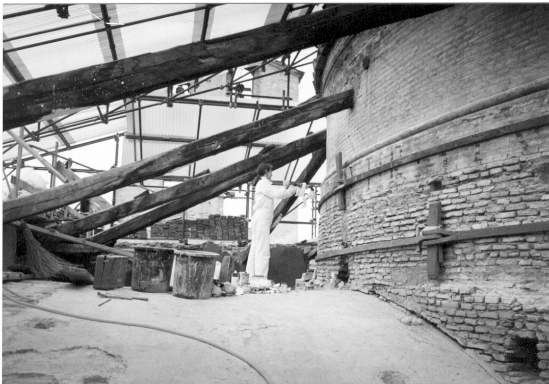
Figg. 47-48. Foto relativa alla perizia n. 13 del 7 maggio del 1994 (1° lotto consolidamento). Dalle foto si possono osservare le cerchiature in ferro forgiato poste a cingere il tamburo della cupola.
