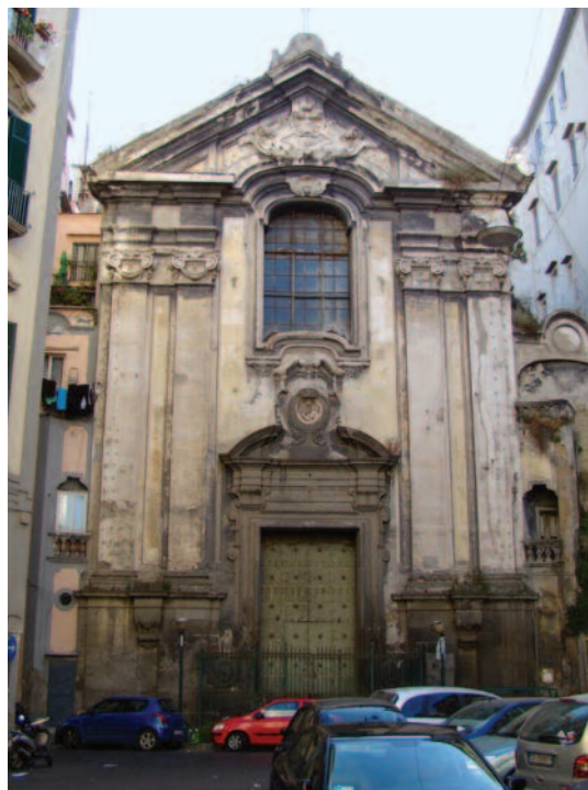
Napoli: facciata della chiesa di S. Maria in Cosmedin o di Portanuova. Chiusa al culto dopo il terremoto del 1980, l'edificio non ha retto ai colpi dell'incuria e dell'abbandono
