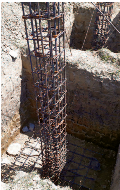
il primo pilastro della nuova scuola
