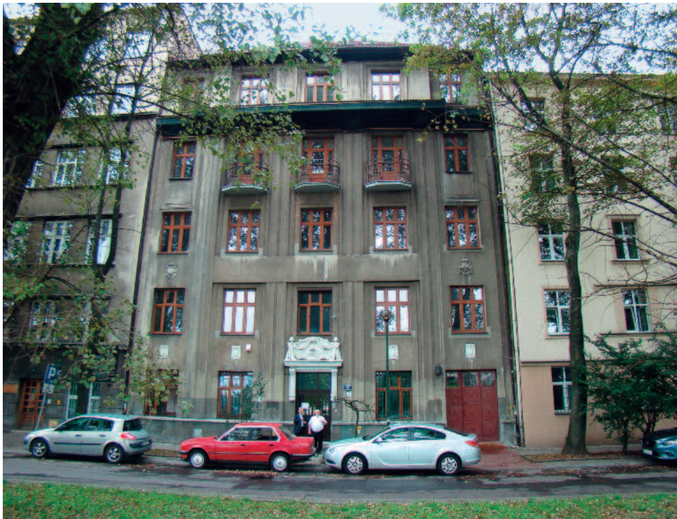
Cracovia - facciata della nuova residenza barnabittica
