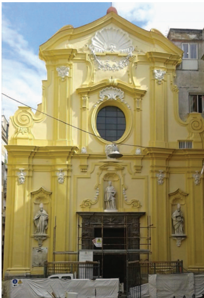
Napoli - l'elegante facciata della chiesa di S. Carlo alle Mortelle, recentemente restaurata. La chiesa fu eretta, a partire dal 1616, su progetti del barnabita Giovanni Ambrogio Mazenta
