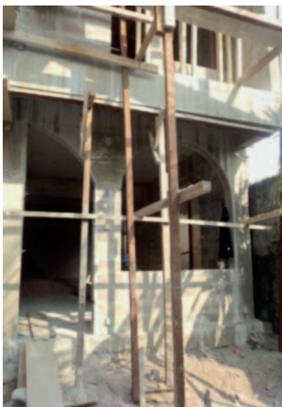
dettaglio della facciata dello studentato
