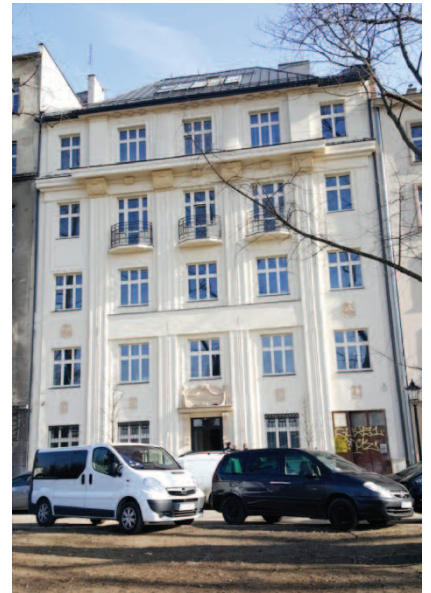
facciata della nuova residenza barnabita a Cracovia
