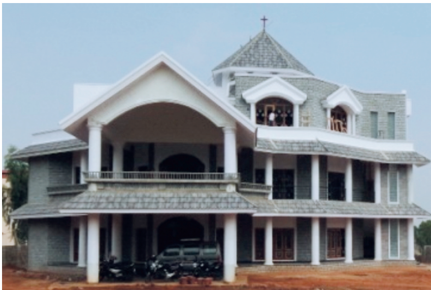
veduta esterna della nuova casa di formazione
