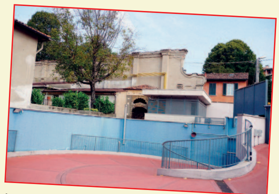
ingresso al parcheggio sotterraneo
