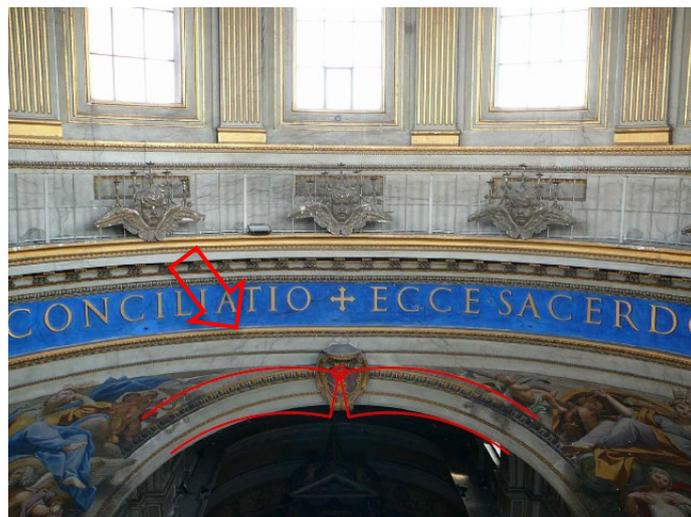
L'intervento che si propone, è quello di "cucire" le lesioni con perforazioni armate subverticali in prossimità delle sole lesioni che andranno realizzate nelle zone in cui non sono presenti decori in modo da ripristinare la continuità della muratura, senza modificarne il comportamento strutturale; inoltre, come già descritto in precedenza, verranno inseriti i tiranti in corrispondenza della loro imposta, in modo da ridurre le spinte orizzontali.
